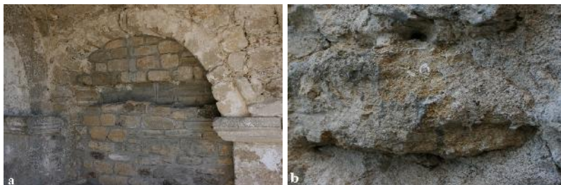
Fig. 8. Mănăstirea Dobrovăț, județul Iași: a – zona de acces în incinta mănăstirii; b – detaliu asupra zidului de incintă și asupra materialelor litice utilizate, cu structură oolitică și fosiliferă accentuată ( V. Pelin, septembrie 2015 )
