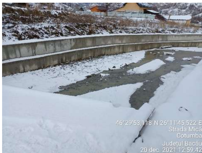
Fig. 7. Regularizare pârâul Cotumba și apărare de mal cu ziduri de beton
