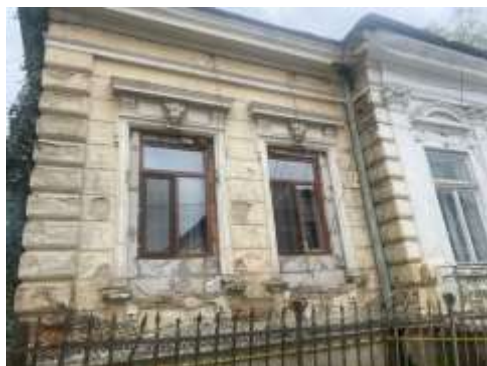
Fig. 13. Schimbarea tâmplărie din lemn în tâmplărie PVC, locuință monument istoric Iași
