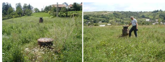
Fig. 25. Gurile de sondă neproductive închise cu cep de beton
