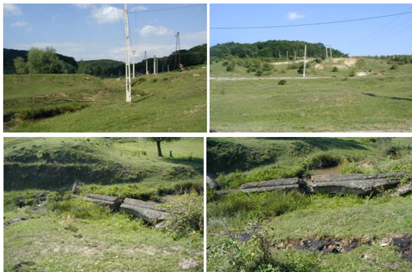
Fig. 9. Zona lacului de acumulare și stăvilarul care a mai rămas de la moara de electricitate din Baie, care a funcționat între anii 1903 și 1935
