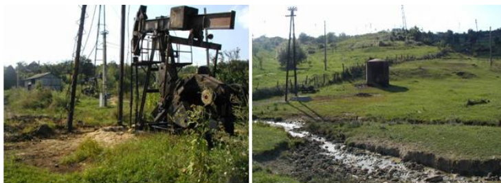
Fig. 22. Imașul cu Sonda Nr. 2 săpată în anul 1902, reformată în anul 1911 și care se află încă în funcțiune, având în fundal hala din tablă zincată ondulată (stânga) ce adăpostește motorul kirat, care printr-un sistem de scripeți cu șufe metalice trăgea deodată păcura din 10 până la 30 de sonde, iar în dreapta este un rezervor vechi în care se aduna păcura extrasă din sonde, având pe vârful culmii Făghean, via bunicului (“in deal la vie”) și livada de pruni
