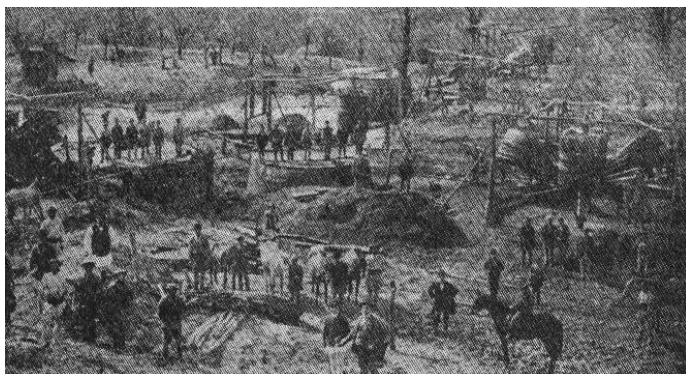
Fig. 3. Un șantier de săparea puțurilor pentru exploatare a păcurii (1866)
