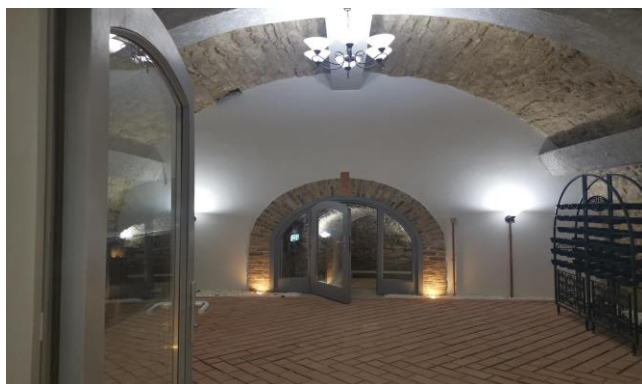
Fig. 7. Consolidarea și reabilitarea pivniței Casei Universitarilor UAIC Iași
