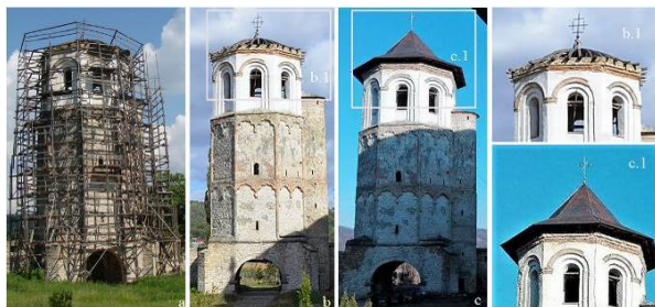
Fig. 19. Turnul clopotniță (1743) al ansamblului monastic Dobrovăț (1503-1504), Iași: a. Turnul în 2013; b. Turnul în 2014; b.1 Detalii cu starea de conservare a turnului după îndepărtarea schelelor; c. Turnul în 2016; c.1 Detalii cu acoperișul turnului restaurat [Sursa foto: Arhivă personală, 2013, 2014, 2016]
